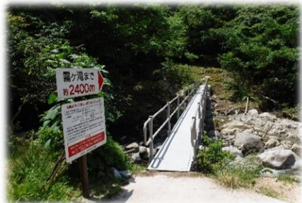
修繕後：霧ヶ滝入口鉄橋
