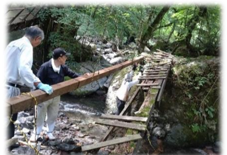
6m角材で橋掛作業
