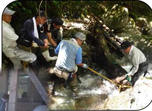
川から橋を引き上げる作業
